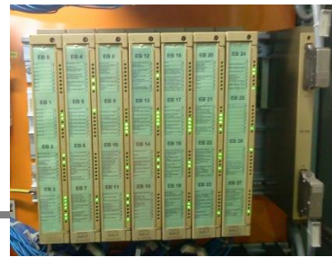
Erweiterungsracks mit Digitalen Ein-/Ausgangskarten
