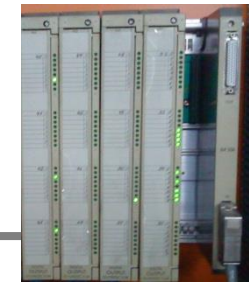
Erweiterungsracks mit Digitalen Ein-/Ausgangskarten
